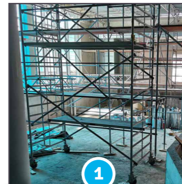
1 Besichtigung des Objekts
